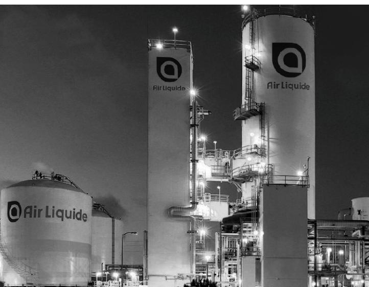
*A produção de oxigênio **on site** exige ar comprimido de altíssima pureza, sem qualquer traço de óleo detectável, conforme a Classe Zero da ISO 8573. Isto se deve ao risco de explosão, quando um combustível (óleo) entra em contato com um comburente (oxigênio). Nos sistemas fornecidos à Air Liquide, o módulo **ModuCarb** é componente obrigatório (EIS) para a total remoção de óleo, não obstante o tipo de compressor utilizado.*
