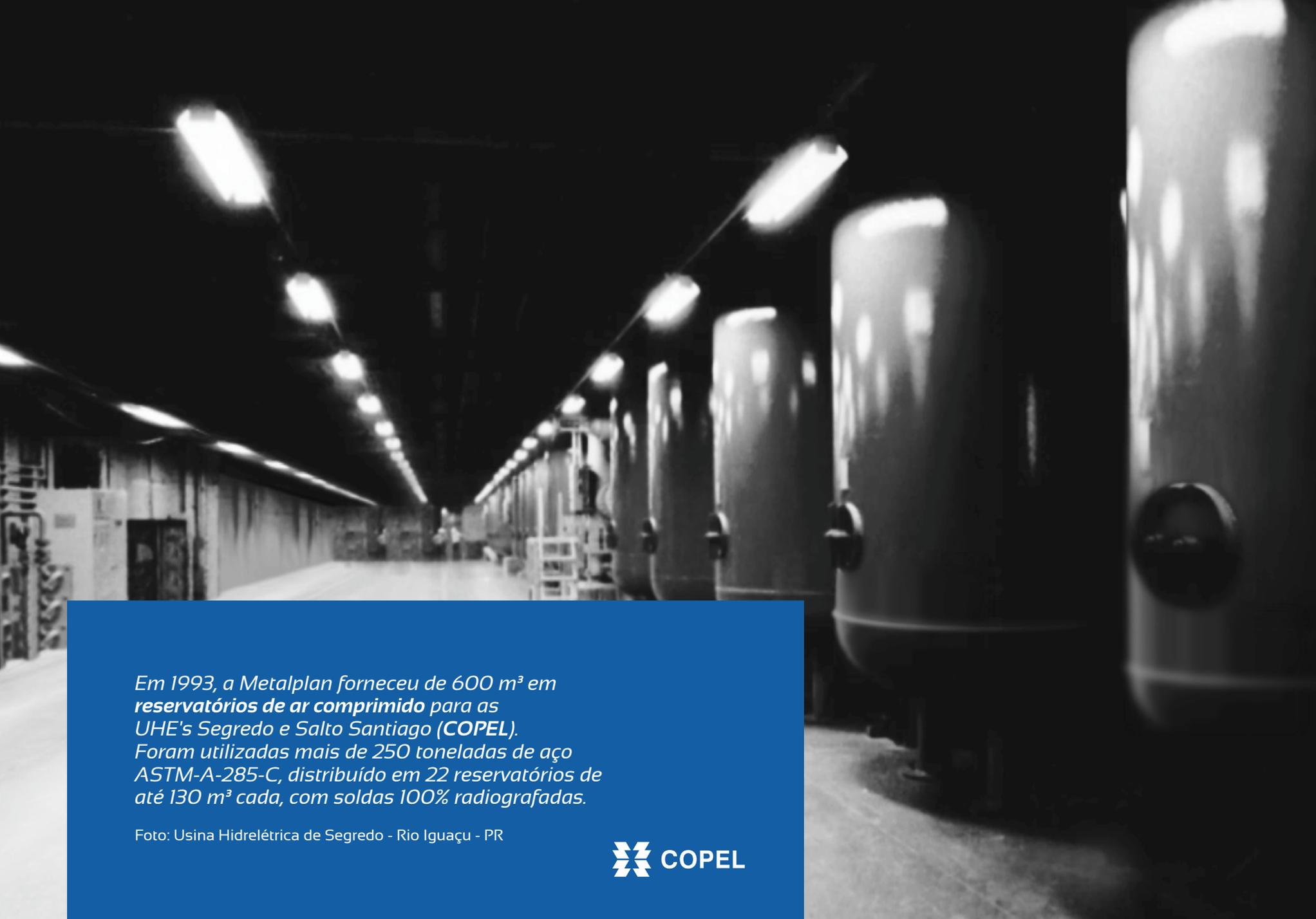
*Em 1993, a Metalplan forneceu de 600 m<sup>3</sup> em **reservatórios de ar comprimido** para as UHE's Segredo e Salto Santiago (COPEL). Foram utilizadas mais de 250 toneladas de aço ASTM-A-285-C, distribuído em 22 reservatórios de até 130 m<sup>3</sup> cada, com soldas 100% radiografadas.*
